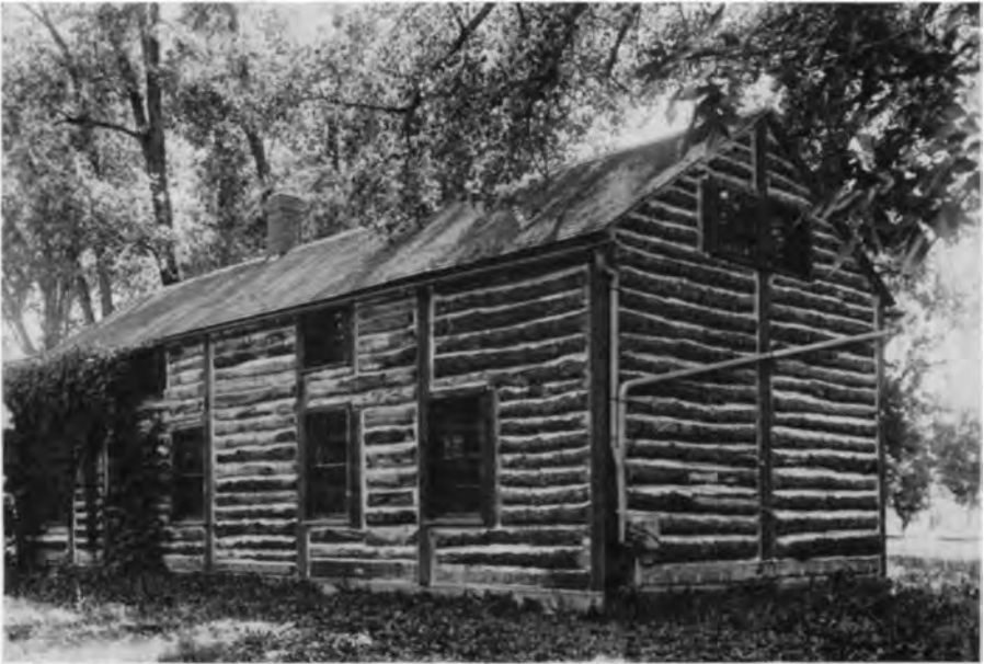
FIG. 15— Pièce sur pièce construction, Brown's Valley, Minnesota. (Photograph by C. E. Peterson, courtesy Library of Congress.)
