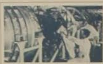
Incoque Rotating Blade Cooling Test Rig in Nishel. Photograph from the collection of the West Point Sound District Museum, courtesy Peter Bremner. Test rig pour l'étude des refroidissements des pales rotatives de l'Iroquois à Nishel. Photographie de la collection du Musée du District de Sound de West Point, avec l'amabilité autorisée de Peter Bremner.
