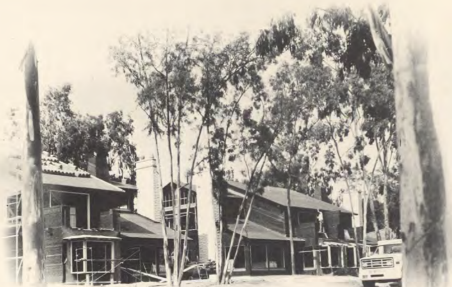
Haciendas de Rancho Santa Fe under construction.
