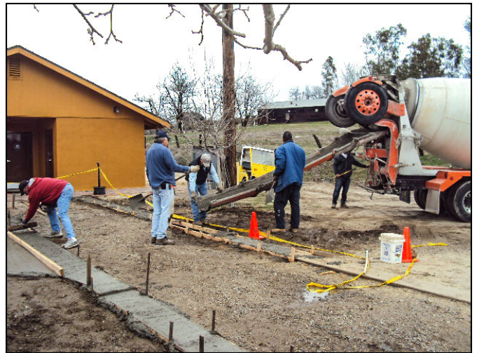
Pouring the concrete "shiners." Dave Tomeraasen Photo
