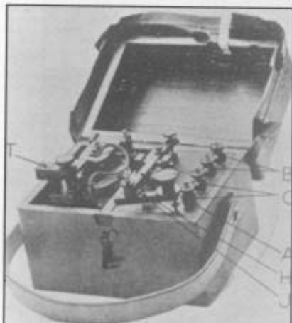
Fig. 45. British "power buzzer"
