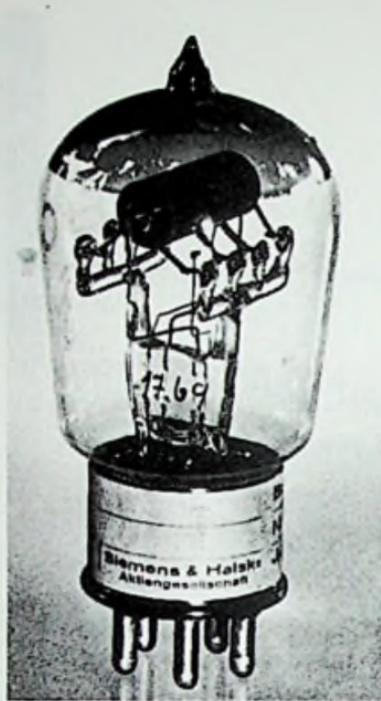
Fig. 21-6. Siemens & Halske BF tube.
