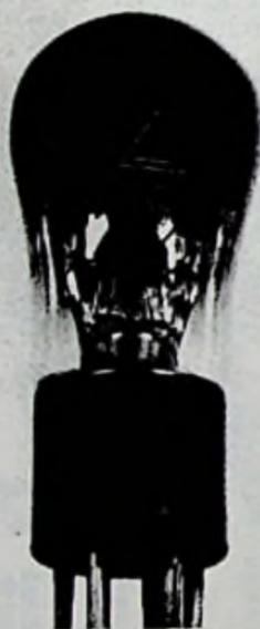
Fig. 21-35. Delta Zweifach/4 multiple tube.
