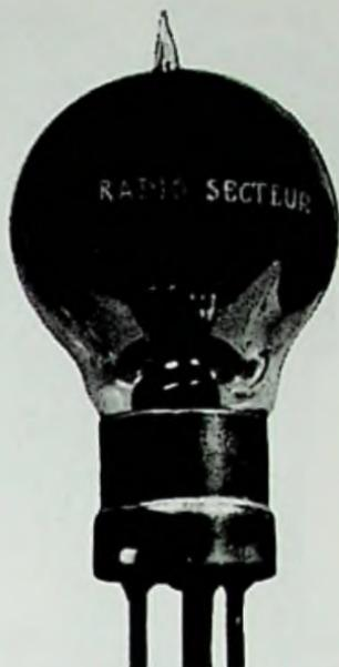
Fig. 19-12. Métal's first ac tube, the Radio Secteur, 1922.
